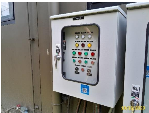
ระบบบำบัดน้ำเสียหลัก/แผนกควบคุมระบบบำบัดน้ำเสีย
