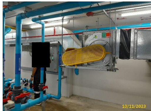
ระบบระบายอากาศสถานที่เก็บสารเคมี
