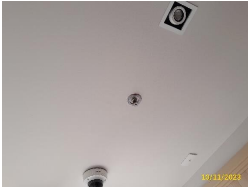
ระบบดับเพลิงแบบกระจายน้ำอัตโนมัติ
