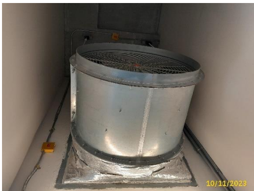
ระบบระบายอากาศโถงลิฟต์ดับเพลิง และทางหนีไฟ
